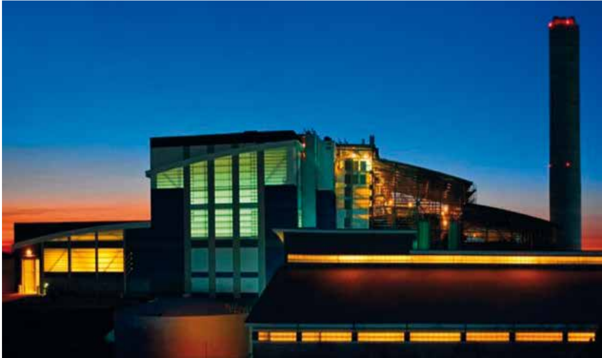
Obr. 76: Pohľad na ZEVO Palm Beach, USA, [43].
